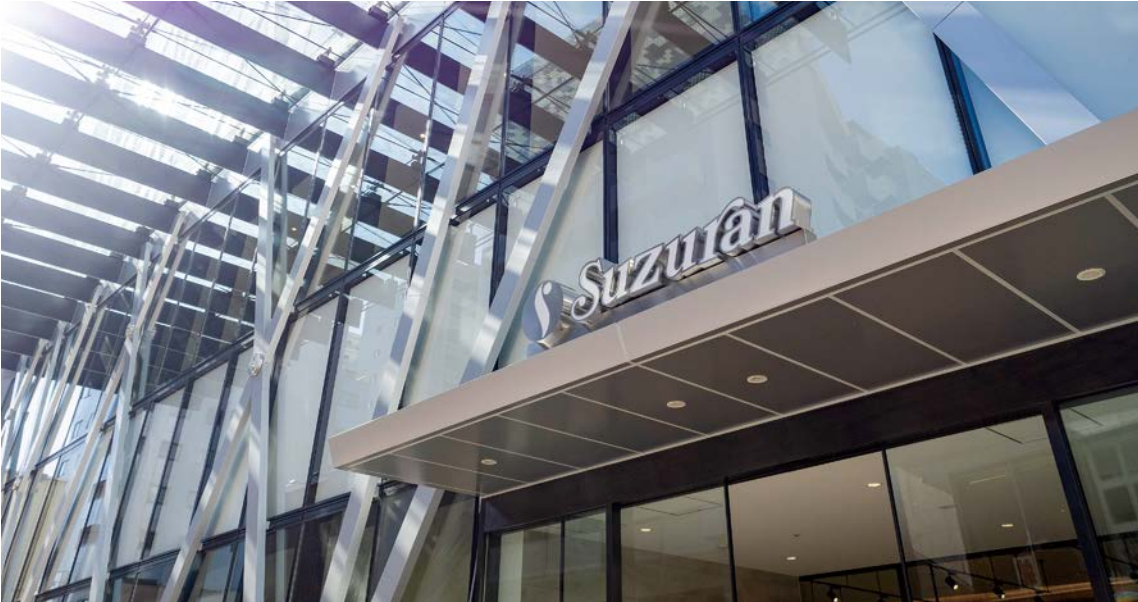
さやもーる沿いに建設中の新店舗
